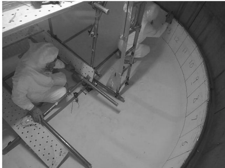
図 8.1.2-2 2015 年度の解体作業前の LV-1 の状況
