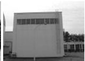
保障措置技術開発試験室施設(SGL)
