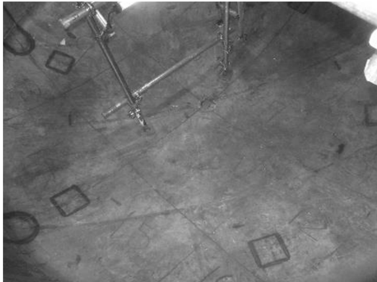
図 8.1.2-4 胴部及び下鏡部撤去後の状況
